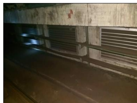
ภาพที่ 2.2-5 แดมเปอร์ระดับรางสำหรับเป็นช่องดูด อากาศออก
