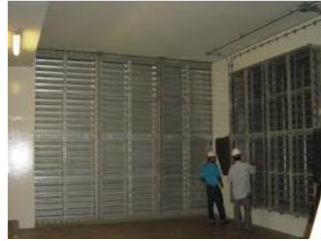
ภาพที่ 2.2-6 ปล่องระบายอากาศจากใต้ชั้นขนาขาลาสู่ภายนอก
