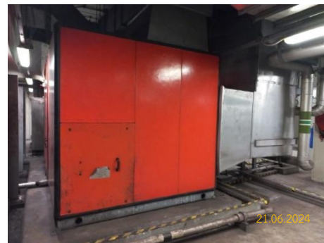
ภาพที่ 2.2-2 ไดอะแกรมและภาพเครื่องส่งลมเย็น (Air Handling Unit: AHU)
