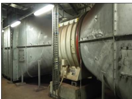
ภาพที่ 2.2-4 ห้องพัดลมระบายอากาศ ใต้ชั้นขานชาลา (UPEF Room)
